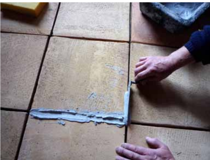
Jointoiement du sol à la truelle (langue de chat). La terre cuite étant un matériau très poreux avant traitement, les joints ne sèchent pas partout à la même vitesse. Les carreaux sont traités un par un avec une finition à l'éponge, ce qui permet de réaliser des joints plus lisses et réguliers.
