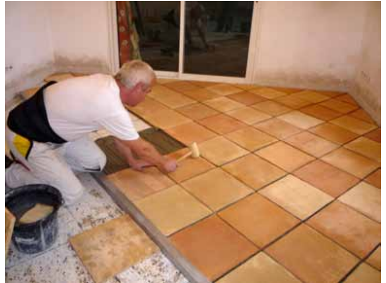
Marouflage des carreaux : Chaque carreau est ensuite marouflé à l'aide d'un maillet en caoutchouc, afin de chasser l'air et de régler le niveau des carreaux entre eux.
