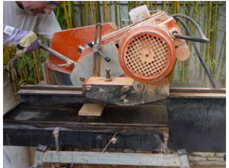
Réalisation des coupes à la tronçonneuse à eau sur table, machine permettant de réaliser des coupes plus précises qu'avec une carrelette, tout particulièrement avec une terre cuite, plus fragile qu'un carreau de grès cérame et d'une épaisseur de 2 cm.
