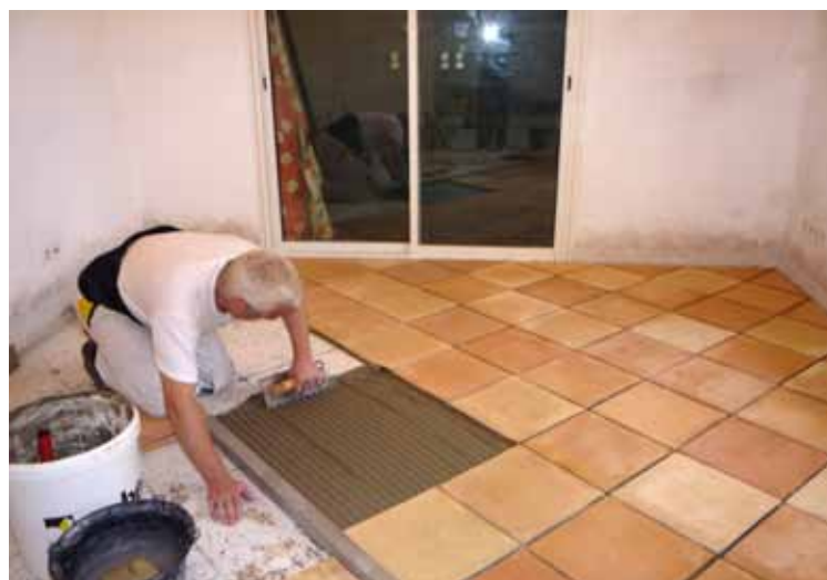
Etalage de la colle à l'aide d'un peigne demi-lune de 2 cm de diamètre. Plus les traits sont réguliers, plus le collage des carreaux sera uniforme.
