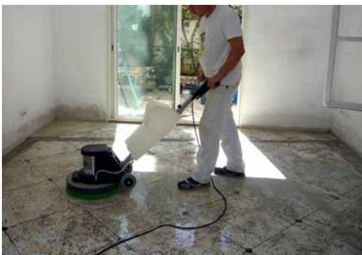
Décapage du sol à la monobrosse. Une pose à la colle nécessite de travailler sur un sol parfaitement propre et sans poussière afin que la colle puisse bien adhérer à la fois au support et au carreau.
