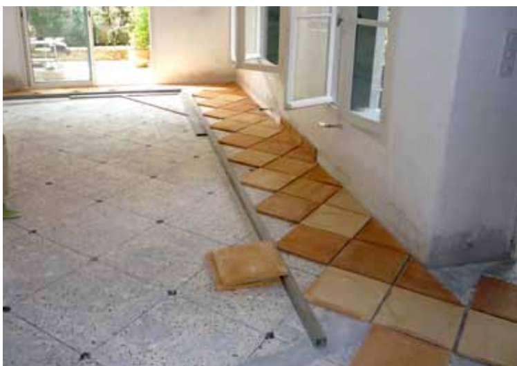
Pose d'équerres et de règles afin de déterminer des angles droits et le calepinage des carreaux. L'objectif étant d'avoir un maximum de carreaux entiers et de placer les coupes dans les endroits les plus discrets, selon la configuration des pièces et le futur emplacement des meubles.
