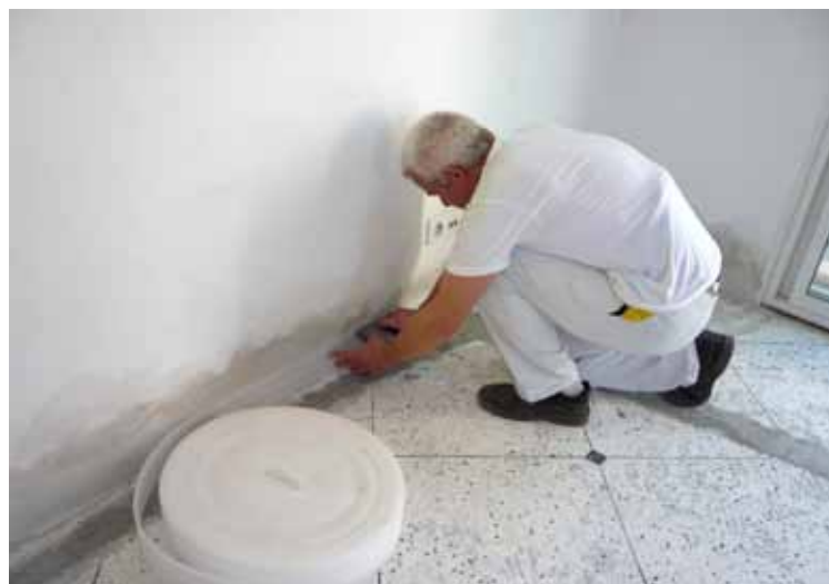
Pose des relevés de plinthes qui vont constituer les joints de dilatation muraux.
