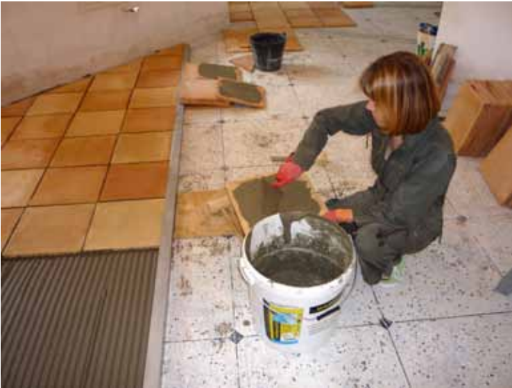
Après nettoyage de chaque carreau de terre cuite, graissage à la colle de l'envers du carreau afin de permettre un double encollage pour une meilleure adhérence.
