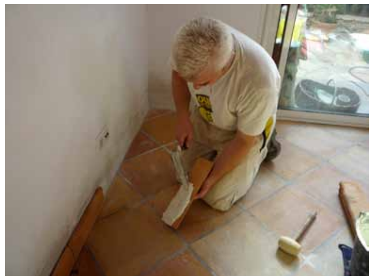
Après réfection du support mural, pose des plinthes avec un adhésif spécial plâtre dans le cas présent
