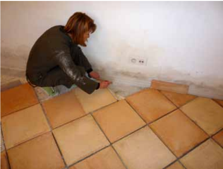
Prise des mesures des coupes à réaliser afin de permettre un traçage précis avant découpe.
